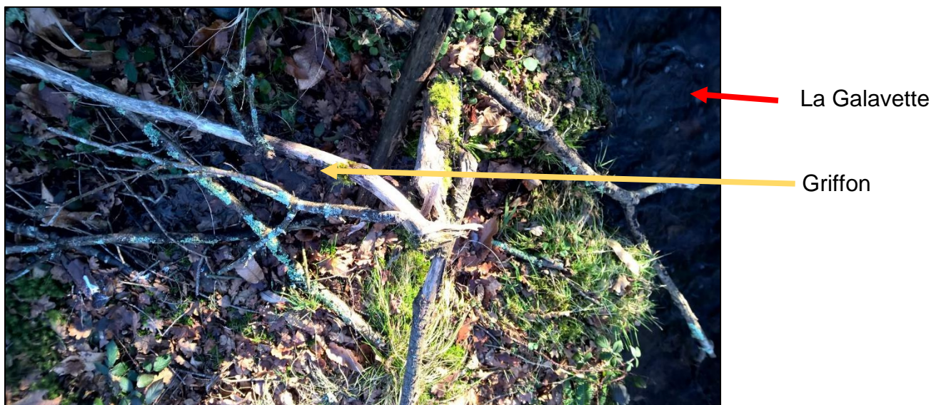
Figure 38 : Exemple de griffon obstrué par des branchages (source : personnelle).
